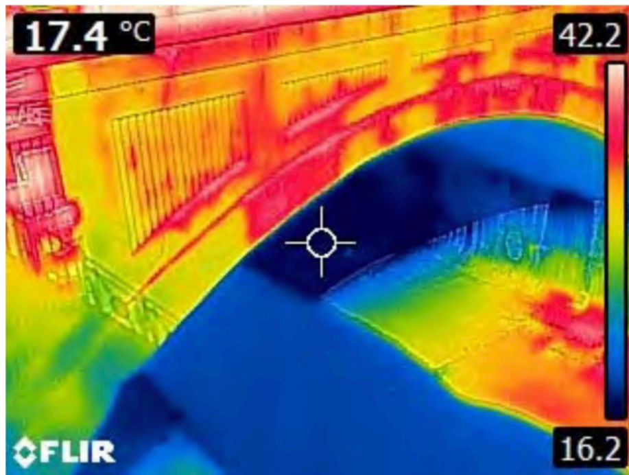
Abbildung 9: Die kühlende Wirkung der Wien ist deutlich zu sehen. Wenige Meter innerhalb des Tunnels werden nur noch 17,4°C gemessen.
