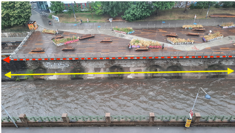
Abbildung 2: Wienfluss bei kleinem Hochwasser nächst Pilgrambrücke/Wienflussterrasse: Die im Bild gelb markierten, schrägen „Kämpfer“, also die Widerlager für das geplante Gewölbe, sind noch nicht überflutet. Bei Starkregenereignissen im gesamten Einzugsgebiet der Wien steigt der Wasserspiegel bis fast zu den großen Abdecksteinen der Mauerkrone (roter Pfeil, größtenteils von der Terrasse verdeckt).
